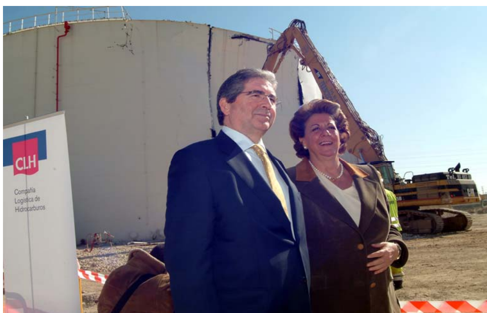
La alcaldesa de Valencia, Rita Barberá, y el presidente de CLH, José Luis López de Silanes, en un momento de la visita realizada a las obras de desmantelamiento de las antiguas instalaciones de CLH en Valencia
